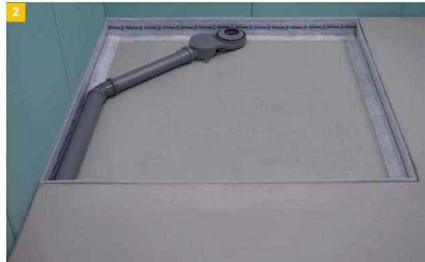
2 Ablauftopf ausrichten und an die Abwasserleitung anschließen.
