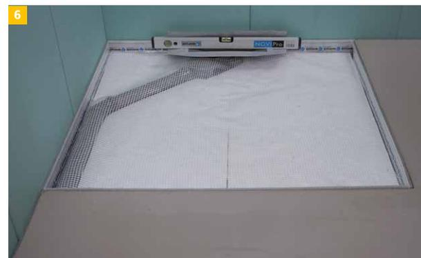
6 ...und mit der AquaDrain® TR-Trennlage auslegen. Den Grundkörper auf den Ablauftopf installieren, mit einer Wasserwaage ausrichten und auf Dichtheit prüfen.
