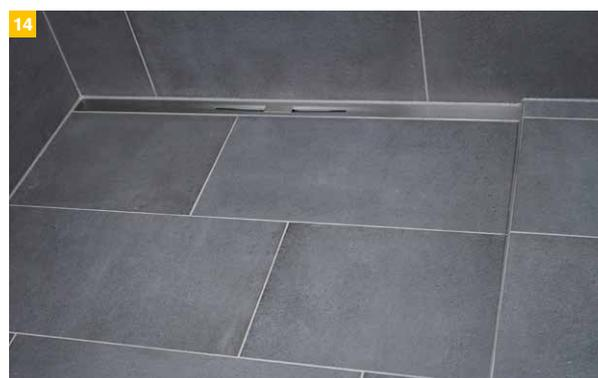
14 ...und die Anschlussfugen mit weichem Füllstoff verschlossen.
