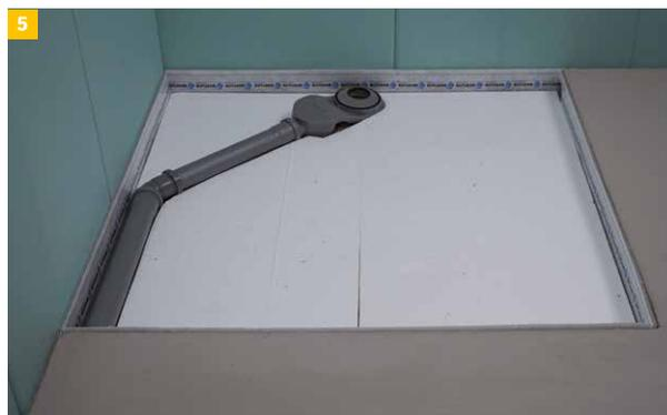
5 ...ggf. Dämmung einbringen...
