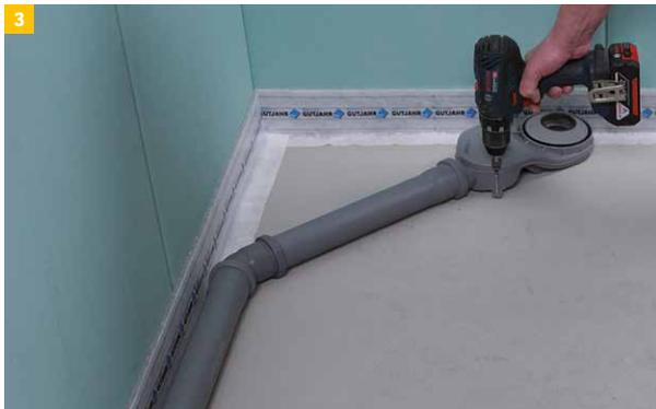
3 Ablauftopf am Untergrund mittels Kleben oder Schrauben fixieren und Dichtheitsprüfung durchführen.
